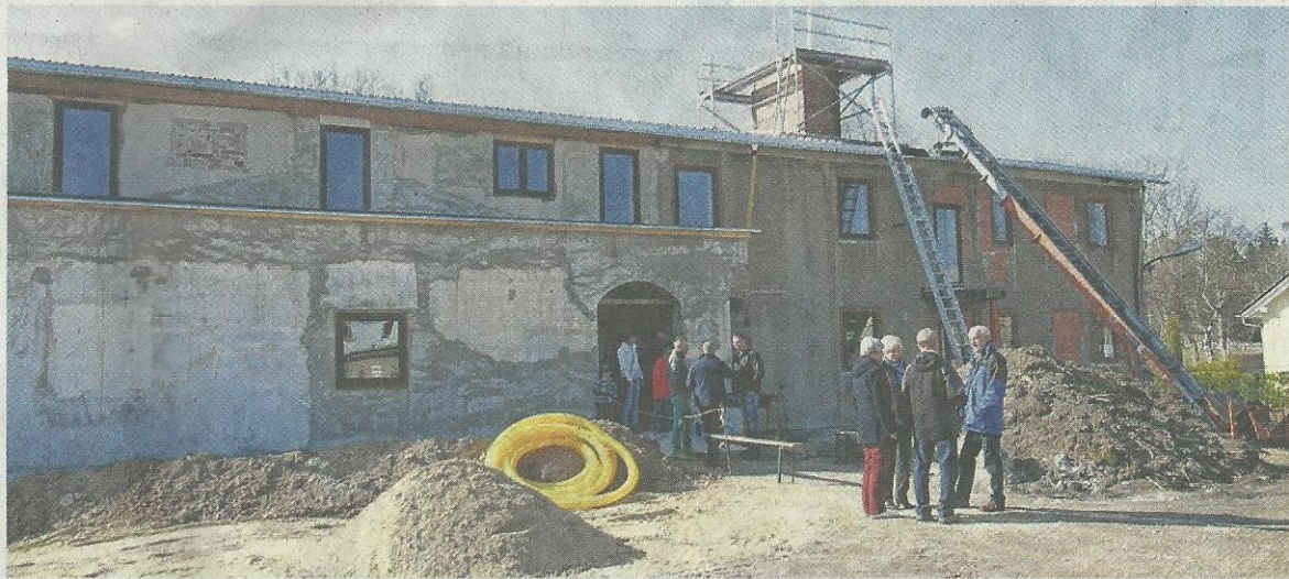
Noch sieht es nach Baustelle aus. Doch schon am 1. Mai sollen die ersten Mieter einziehen.
